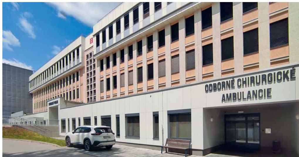
Pohľad na budovu chirurgie s novou nadstavbou.
