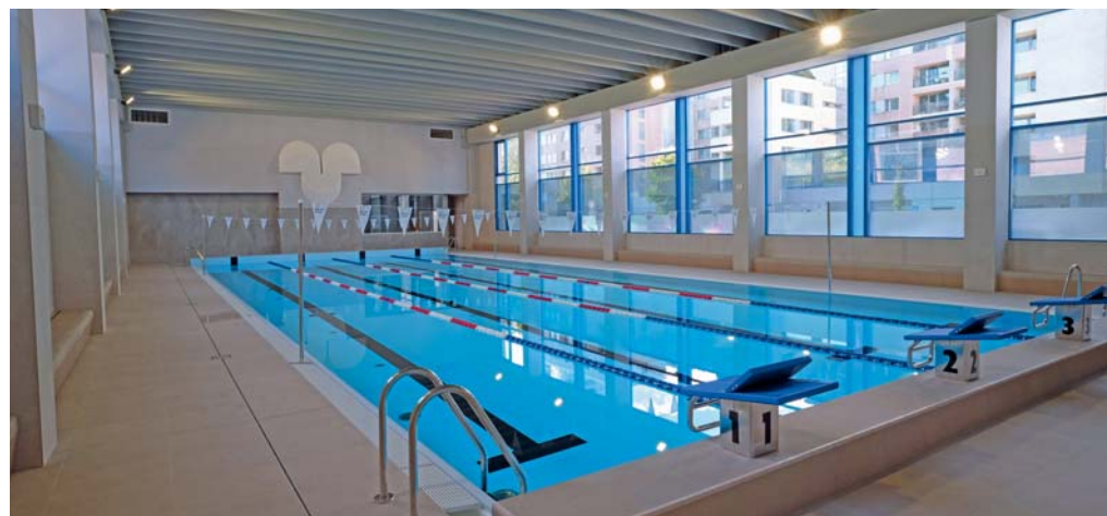
Legendárna bratislavská plaváreň po kompletnej sanácii vzduchotechniky a odvlhčovacích systémov.
