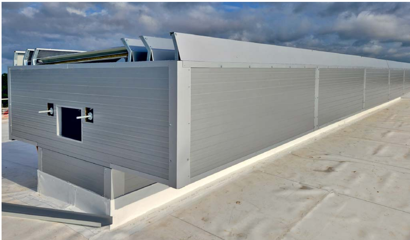
Systém strešného labyrintového ventilátora RV1-II. Zariadenia RV1-II s 2 pohonmi je možné zostaviť do dĺžky 21 m.
