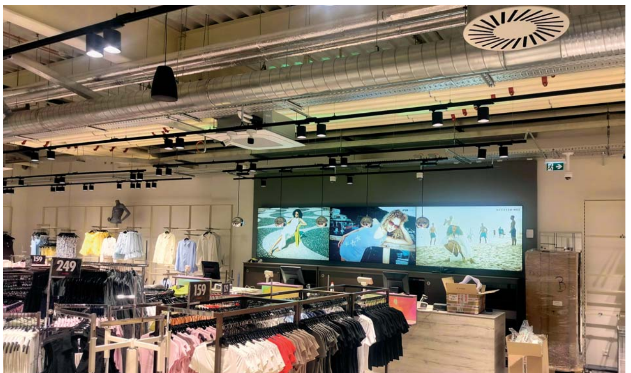
Klimatizace a vzduchotechnika se v brněnském obchodě New Yorker měnila bez přerušení prodeje.
