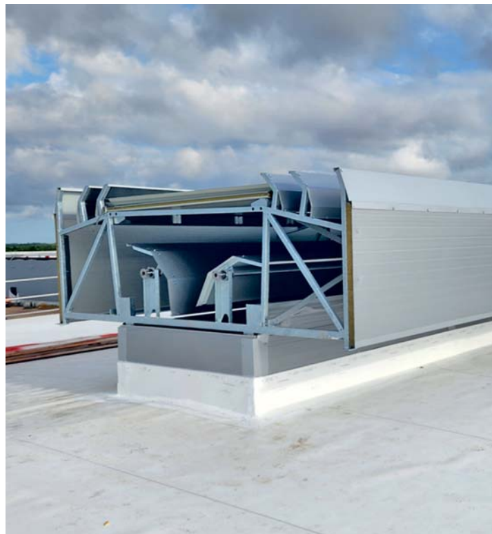
Prebiehajúca montáž RV1-II, kde v reze vidíme komponenty systému.
