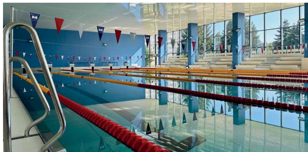
Zmodernizovaná bazénová hala MTF STU s novým systémom mikroklimy a odvlhčovania.
