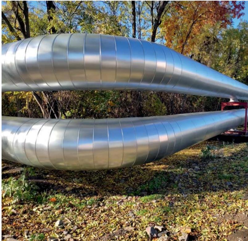
V Praze-Michli se měnilo 215 metrů izolovaného horkovodu DN700.
