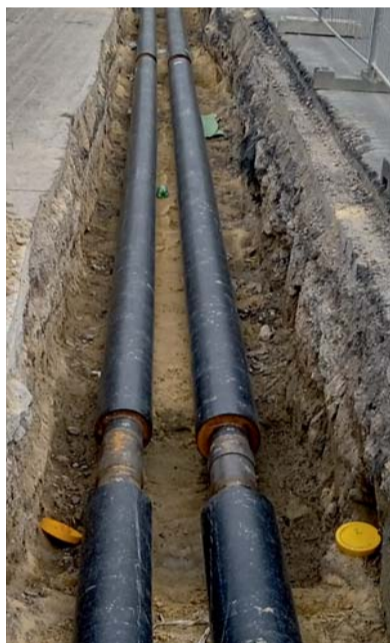
V Černokostelecké měří modernizovaný úsek horkovodu 340 metrů.
