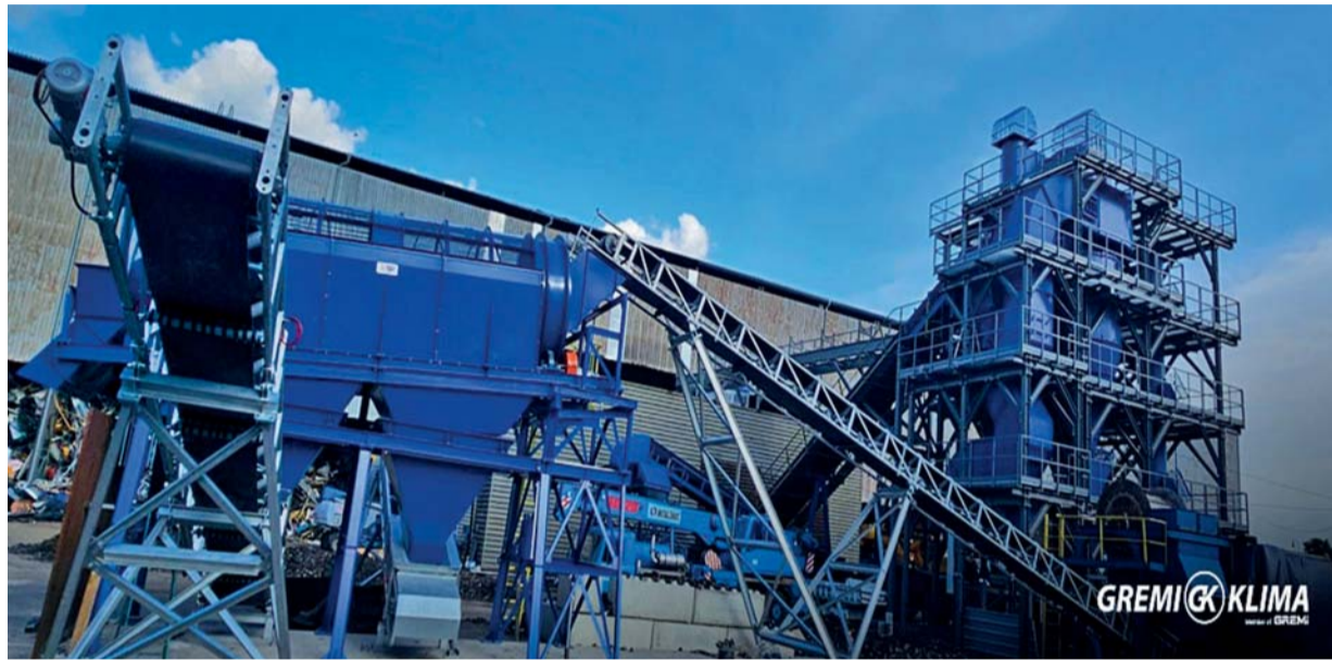
Dodávka nové technologie odsávání při recyklaci kovového šrotu ve společnosti Metalšrot Tlumačov patří mezi letošní nejzajímavější zakázky třinecké pobočky závodu GreMi KLIMA Milevsko.
