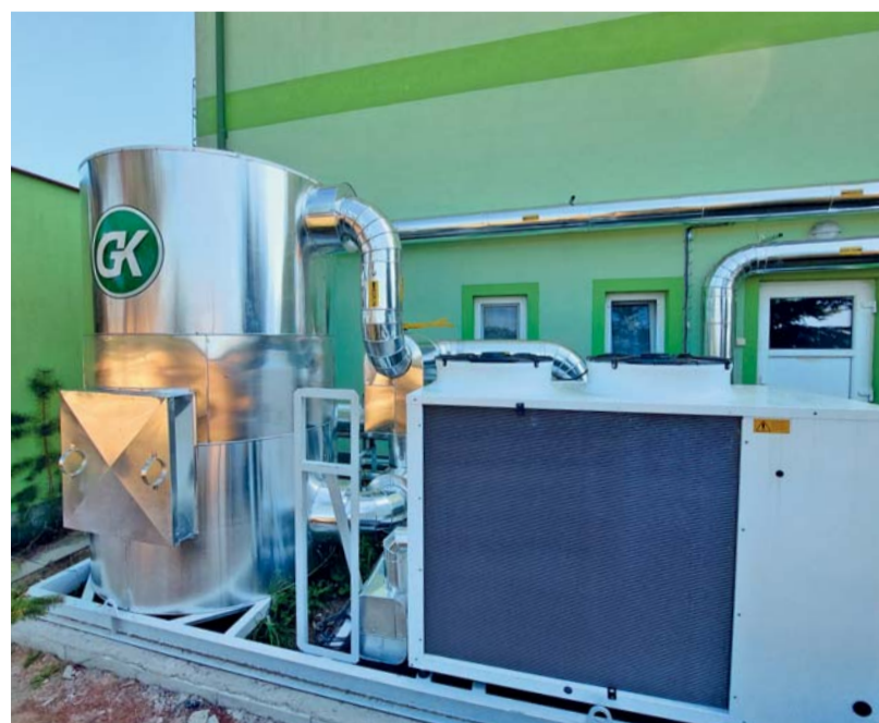
Jednotka úpravy plynu pro bioplynové stanice.
