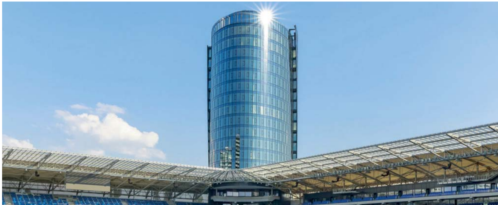
O servis VZT na budove Tower 5, ktorá je súčasťou Národného futbalového štadióna, sa stará pobočka GreMi v Bratislave.
