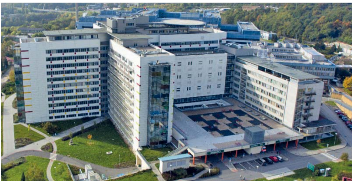
Fakultní nemocnice Motol, největší zdravotnické zařízení v Česku, má v budovách přes 2300 požárních klapek. O jejich revizi se stará Luwex.
